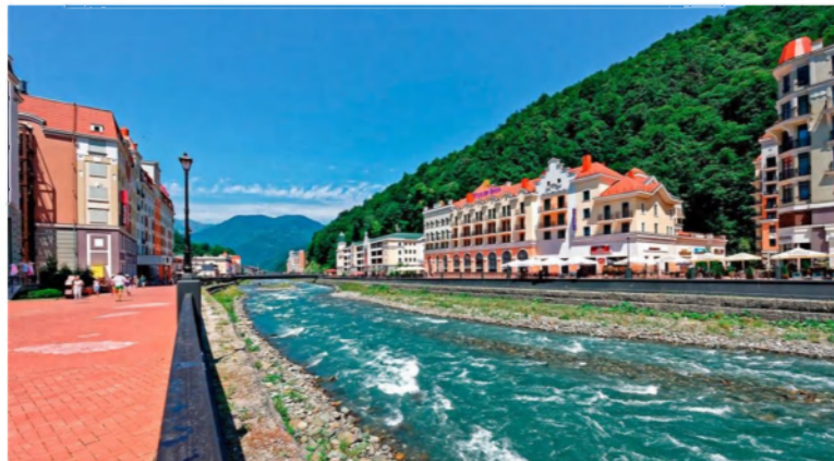
Рисунок 3 – Результат спрямления горной реки (р. Мзымта) вызывающий ускорение ее течения при взятии в искусственные берега.
